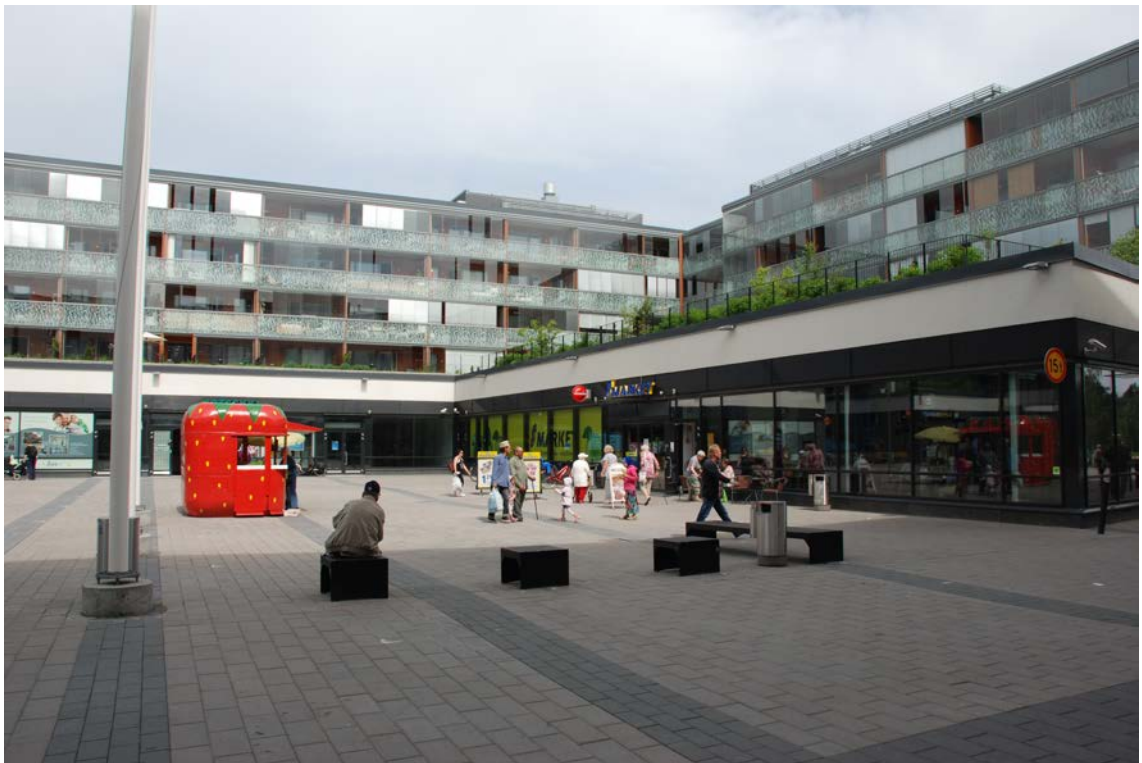
Kuva 3. Tori, asuinrakennukset ja viherkatto (kesäkuu 2014).
