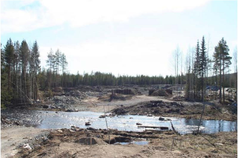
Kuva 2: Maiseman muutos Kolmisoppijärven Tuhkajokisuussa aiheuttaa vielä aikojenkin päästä kipeitä tunteja entisissä asukkaissa. Kuvassa patotyömaa toukokuussa 2009 (Anneli Meriläinen-Hyvärisen kokoelma).
